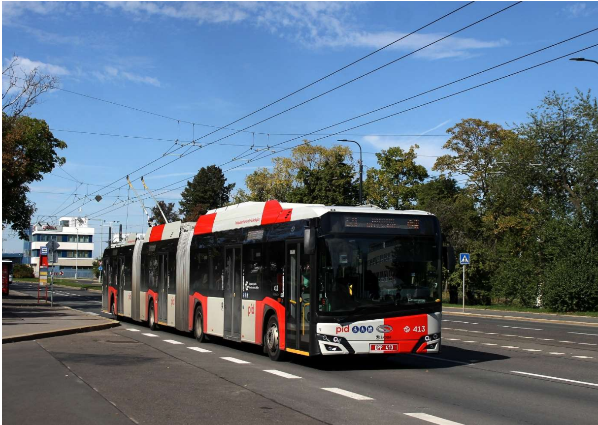
30. ábra: Prágában a teljes felszámolás után 2023 óta reneszánszát éli a trolibuszközlekedés: a repülőtérre vezető, sűrű 59-es vonalon Solaris Trollino 24 duplacsuklós járművek közlekednek. [4] [5]
